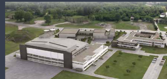
Pápa SAC Hangar Complex
